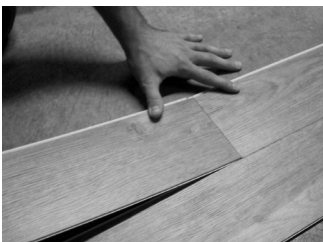
Fig. 5 - Incliner l'extrémité de la planche suivante
